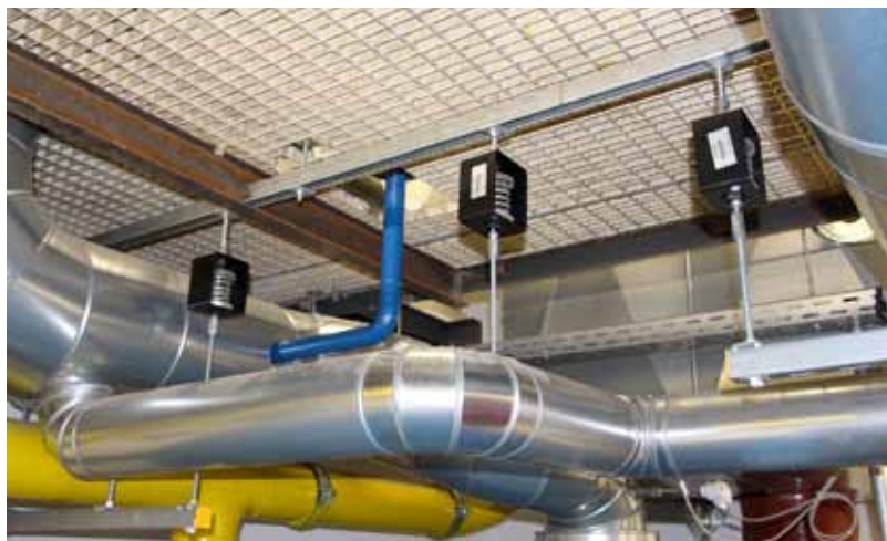
Drgania przewodów rurowych można skutecznie izolować za pomocą wibroizolatorów podwieszanych
